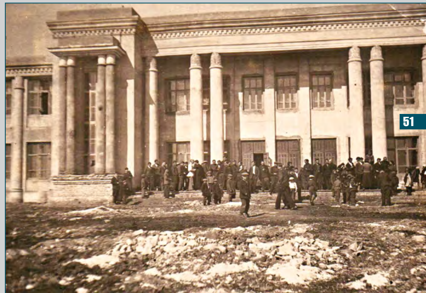
1938 г. Открытие «белого корпуса», построенного силами студентов
