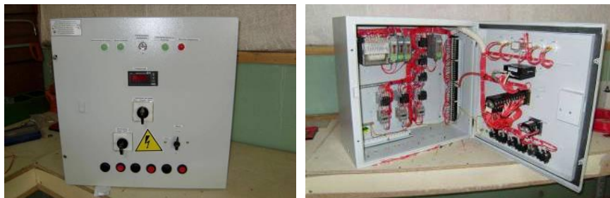
Рис. 18. Щит для управления и контроля приточной вентиляцией
